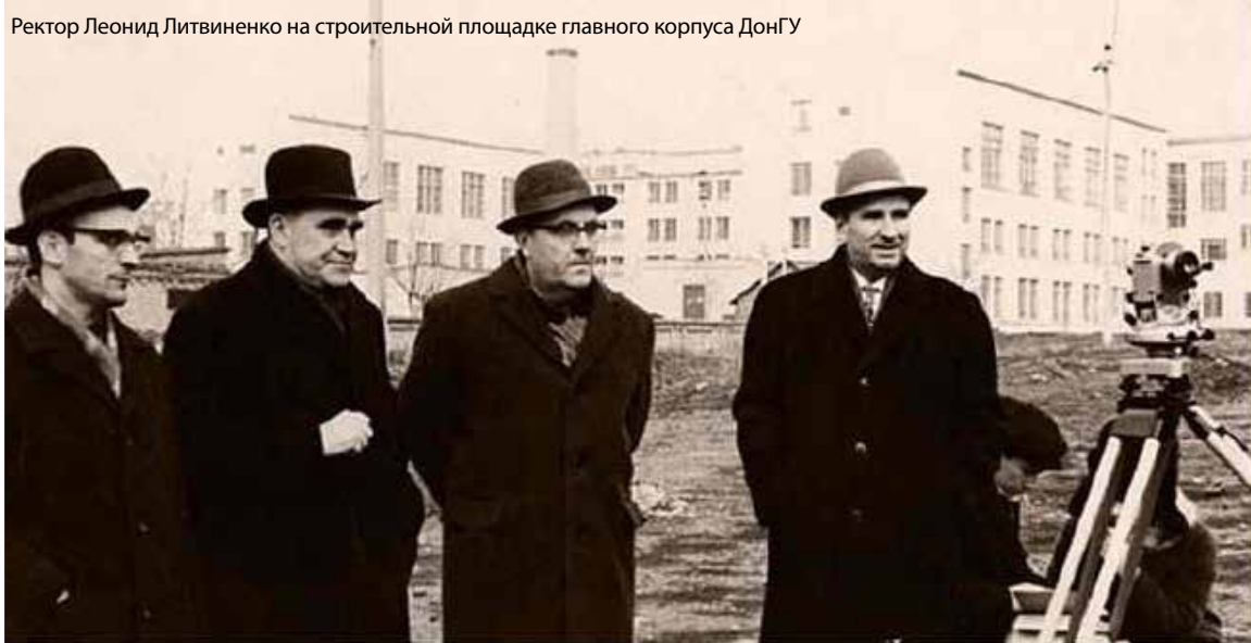
Ректор Леонид Литвиненко на строительной площадке главного корпуса ДонГУ
